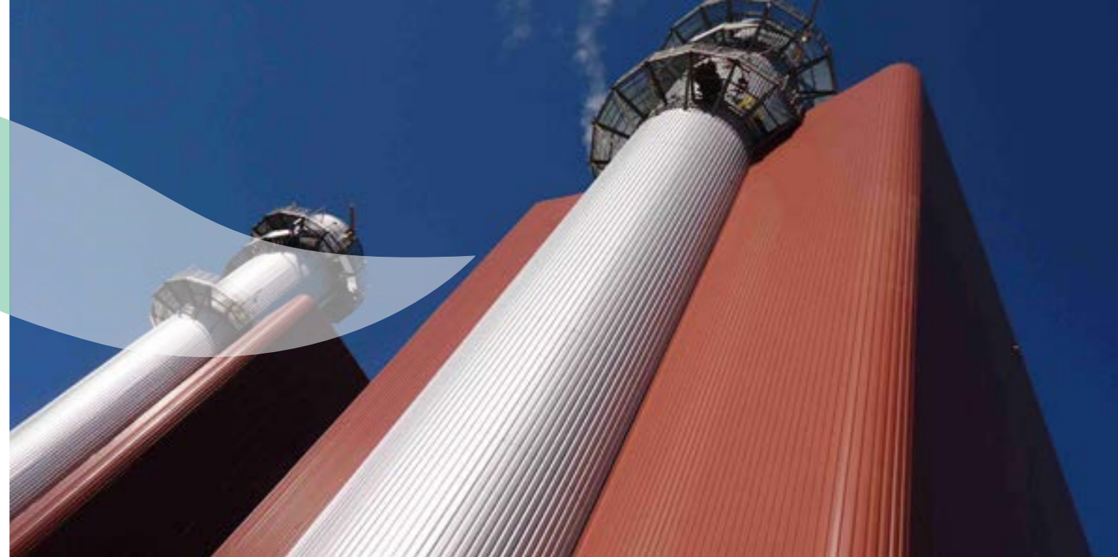
Aprilia Combined Cycle Sorgenia (ITALY) 2 HRSG behind 2 x 260 MW GT
