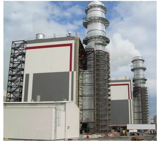
Fig. 8 – Hamm Uentrop HRSG
