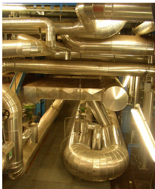
Fig. 4: Vertical HRSG intricate piping arrangement sample.
